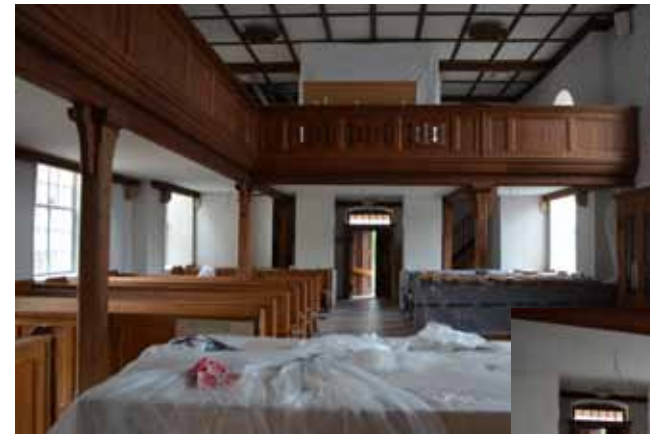
Ein kleiner Raum für die Elektrosteu- erung der Kirche (links) und ein kleiner Stauraum (rechts) konnten durch Ausbau von 3 Bän- ken im hinteren Bereich bei der Treppe re- alisiert werden.
