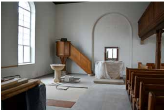
Der neue Boden ist verlegt, die Holzdielen werden erhöht neu eingesetzt.
