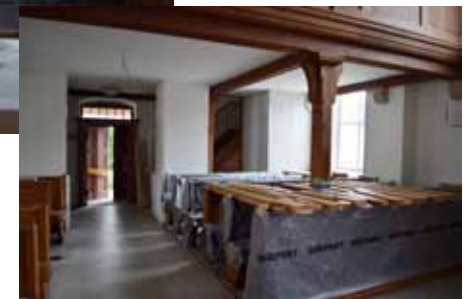
Die neue Turmuhrsteuerung und auch die mobile Rampe für einen barrierefreien Zugang werden hier ihre Plätze finden.
